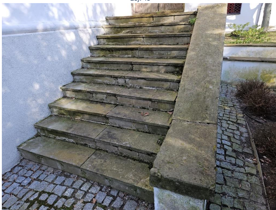
Zdj. 50 Schody nr 7 - uszkodzona okładzina schodów
