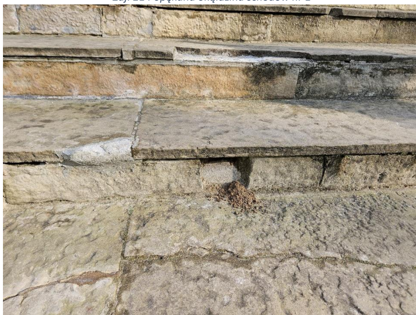
Zdj. 22 Uszkodzenia okładzin schodów nr 1
