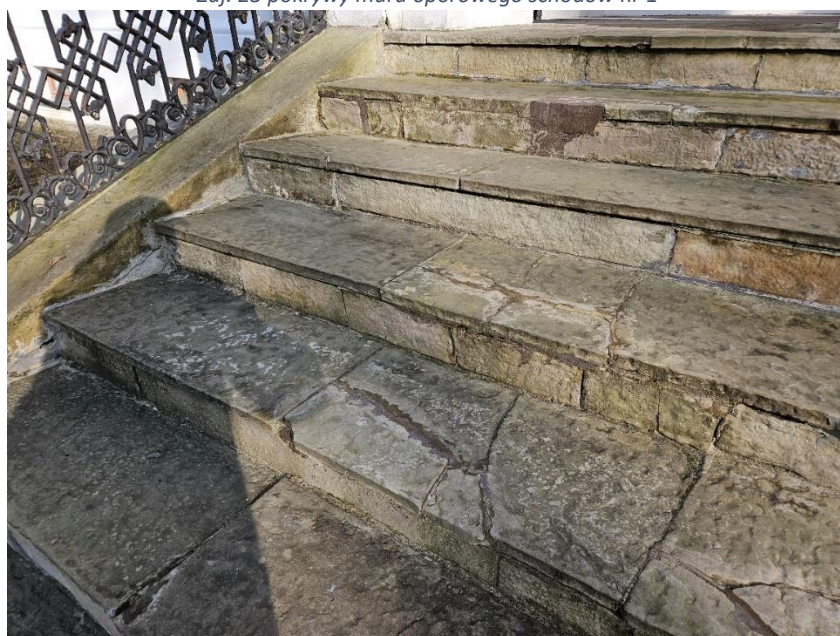
Zdj. 24 Uszkodzenia okładzin schodów nr 1
